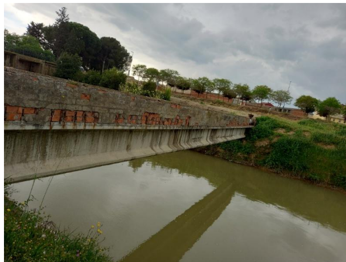
Imagen 2. Fotografía trazado actual de la plataforma existente para paso elevado de tubería sobre Canal Imperial de Aragón.
